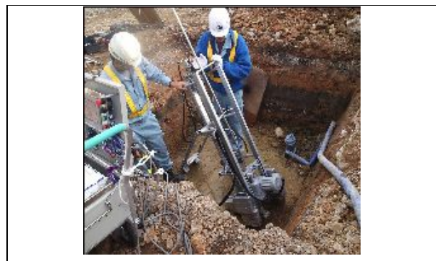
写真 - 1 NSWSによる計測状況
