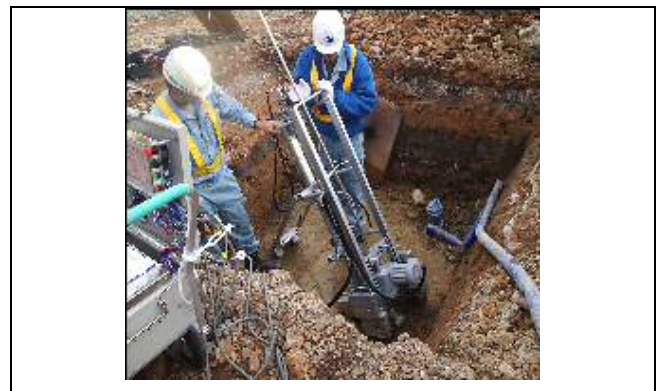
写真-1 NSWSによる計測状況
